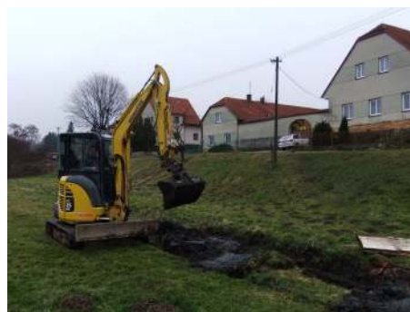
Čištění vodního náhonu u fotbalového hřiště.
