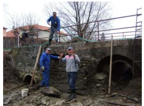
Oprava mostu u Mateřské školy
