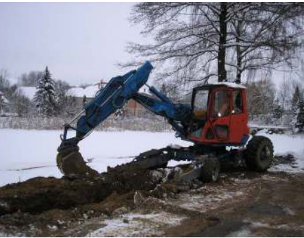
Kanalizační stoka u rybníka musela být hotova před napuštěním rybníka.
