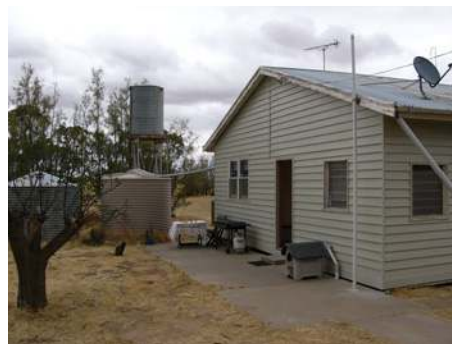
Farma s nádržemi na dešťovou vodu.
