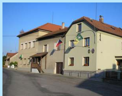
Budova obecního úřadu v Tisové.
