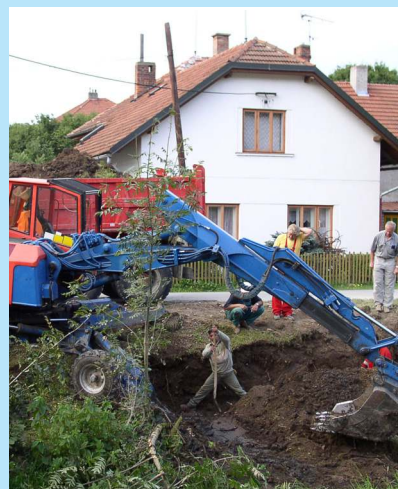
Výstavba hlavních kanalizačních řadů I. etapy v Tisové skončila. Foto Miroslava Dobešová
