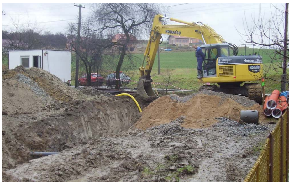
Výstavbu I. etapy kanalizace a čistírny odpadních vod v Tisové provádí firma Profistav.
