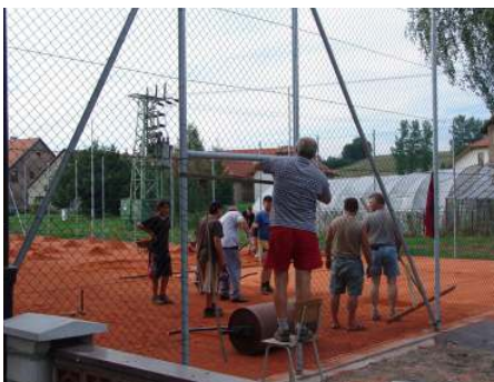
Zatímco se upravoval povrch hřiště, Luděk Husák dokončoval vstupní branku.
