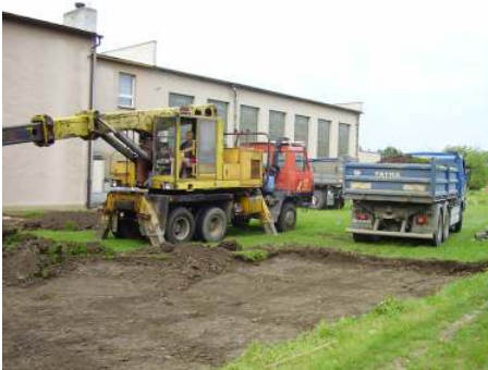
Tisovská firma GAPA při zahájení prací na výstavbě hřiště.
